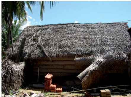
Eine typische Hütte: zugig, instabil und dunkel. In der Regenzeit bietet sie keinen Schutz.
